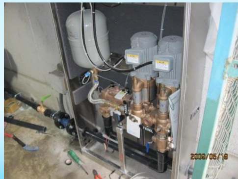
⑤増圧(ブースター)ポンプ据付 および配管施工中
