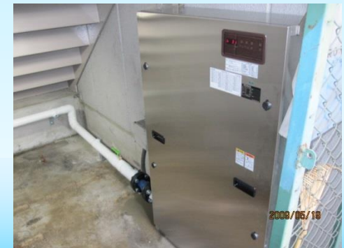
⑥増圧ポンプにて給水開始
