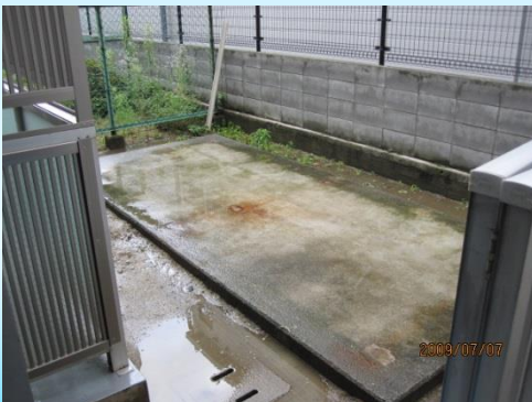
④受水槽撤去完了後
