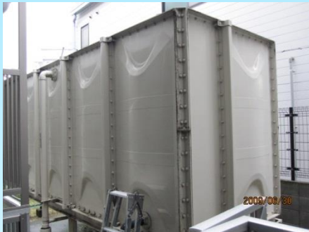
①受水槽撤去前
