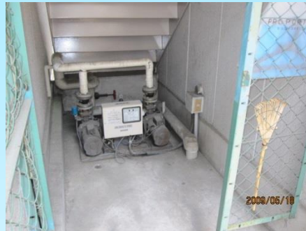
⑤増圧(ブースター)ポンプ据付 および配管施工中
