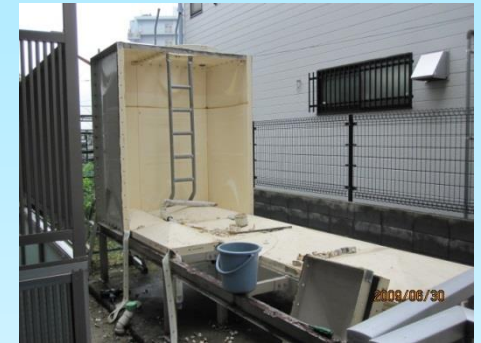
③受水槽撤去作業中
